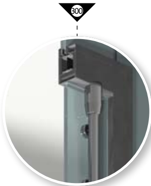
Detail 300 Bovendetail glasdeur en kozijn
